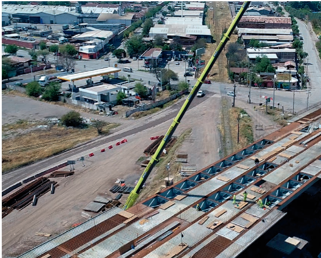
Viaducto de acceso a la ciudad de San Felipe.
