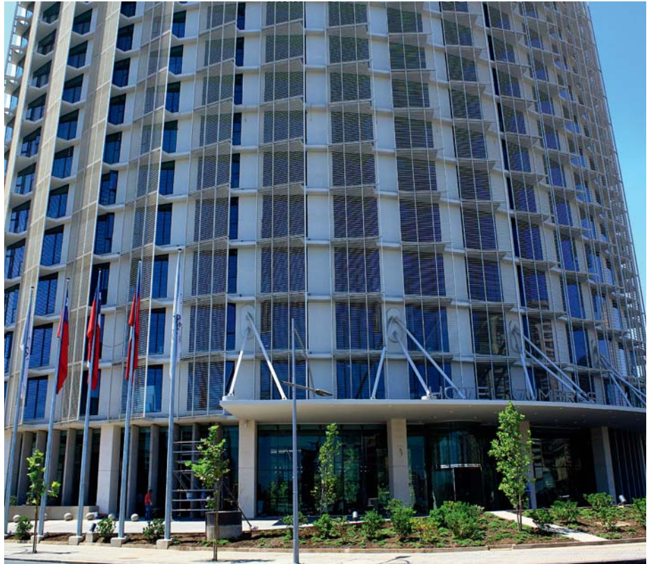
Fachada del Hotel Cumbres en Vitacura, donde se destacan especialmente los cortasoles.
