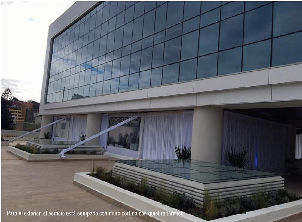
Para el exterior, el edificio está equipado con muro cortina con quiebre térmico.
