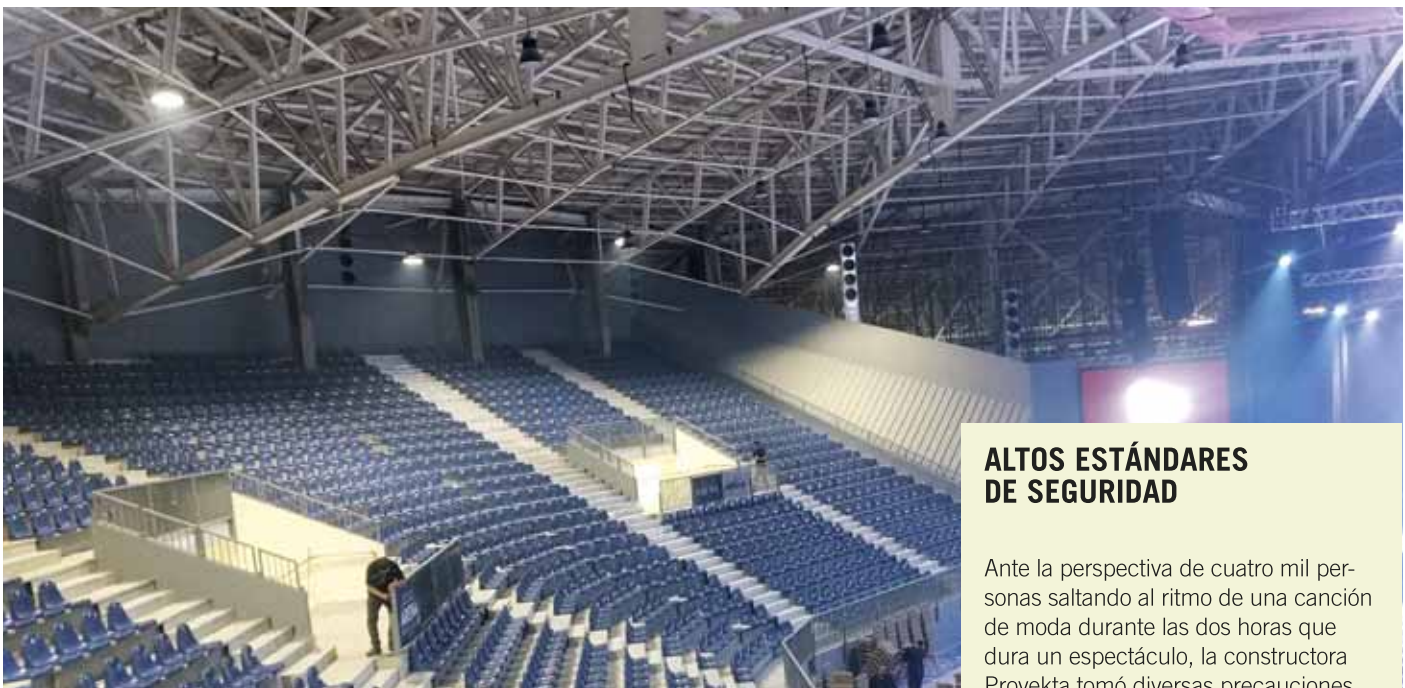
Gran Arena Monticello cuenta con 3.200 butacas en las graderías y 800 sillas móviles en la cancha.
