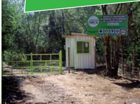
Control de acceso Collipulli
