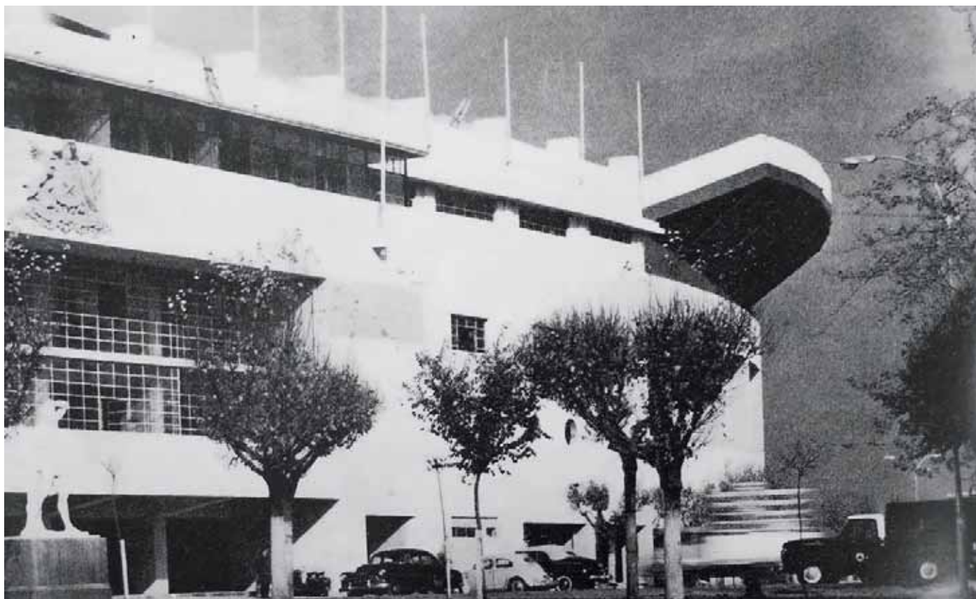
Voladizo del Estadio Nacional, 1962.
