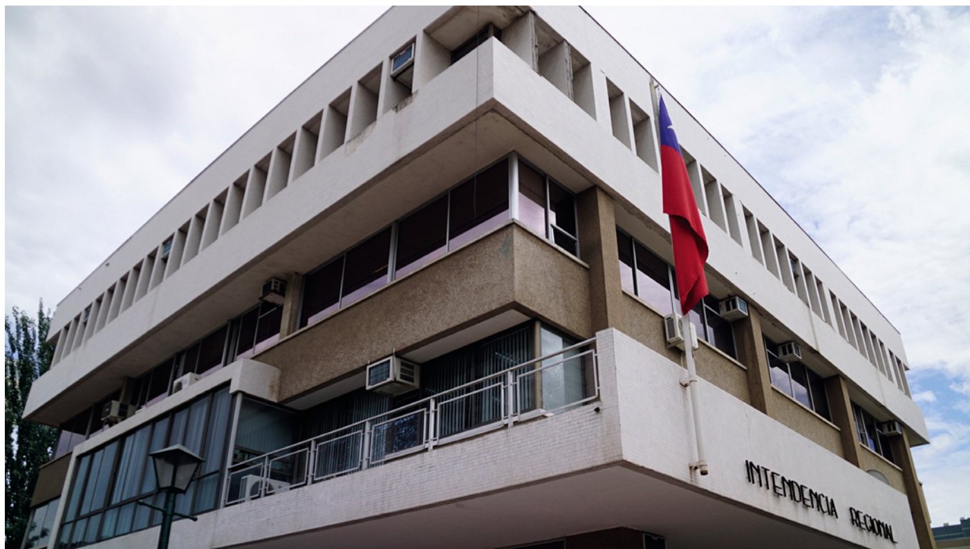
Intendencia de la Región de O'Higgins, 2016. Imagen general del edificio de la Intendencia de la Región de O'Higgins, ubicado en la plaza Los Héroes de Rancagua. Fotografía Carlos Candia.
