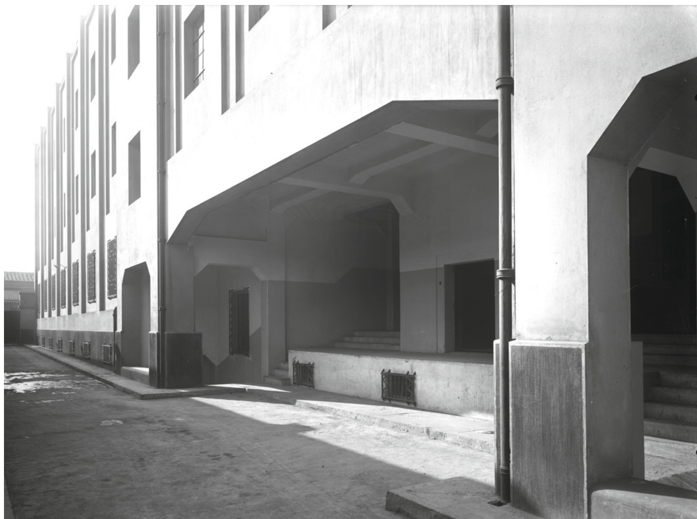
Fachada interior del edificio de la Dirección General de Aprovisionamiento del Estado.
