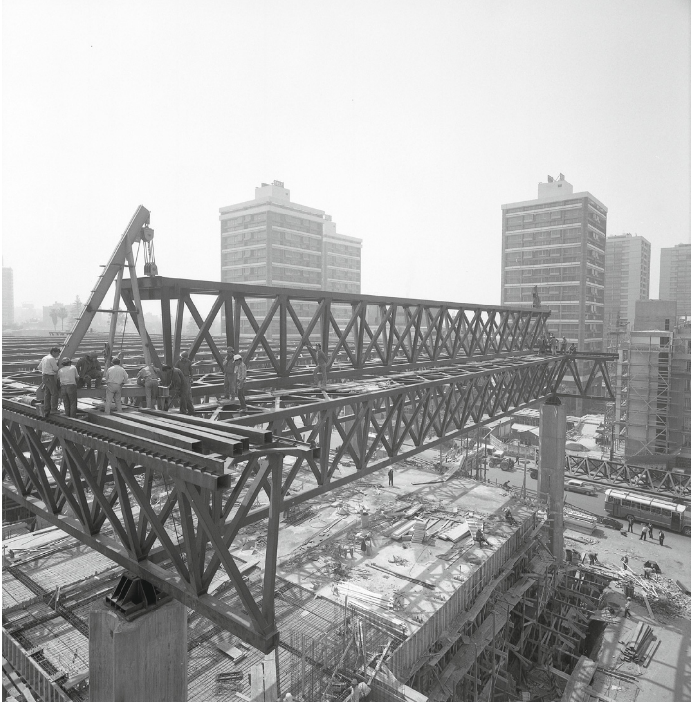
Edificio Gabriela Mistral (UNCTAD III) en obras, 1971.
