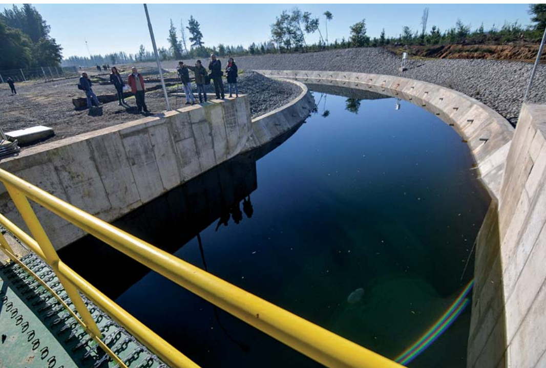
Canal de aducción.
