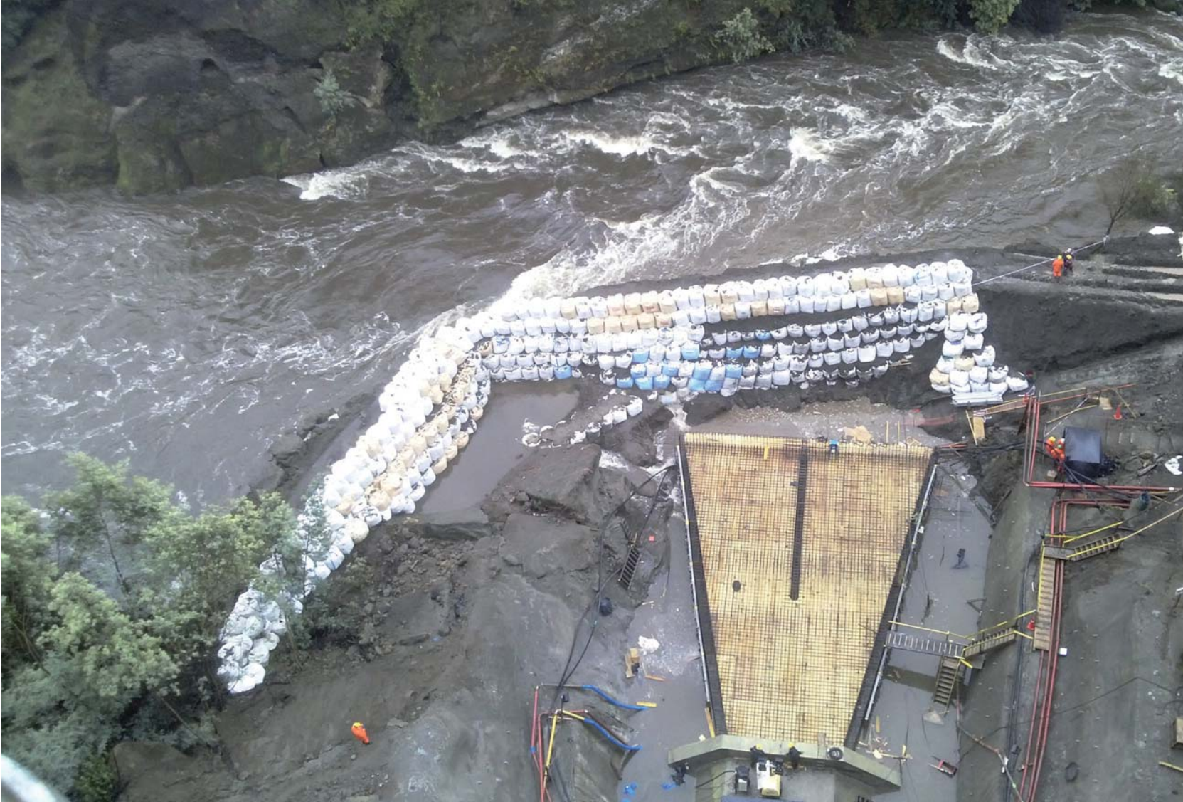
Canal de aducción de 150 metros de largo.
