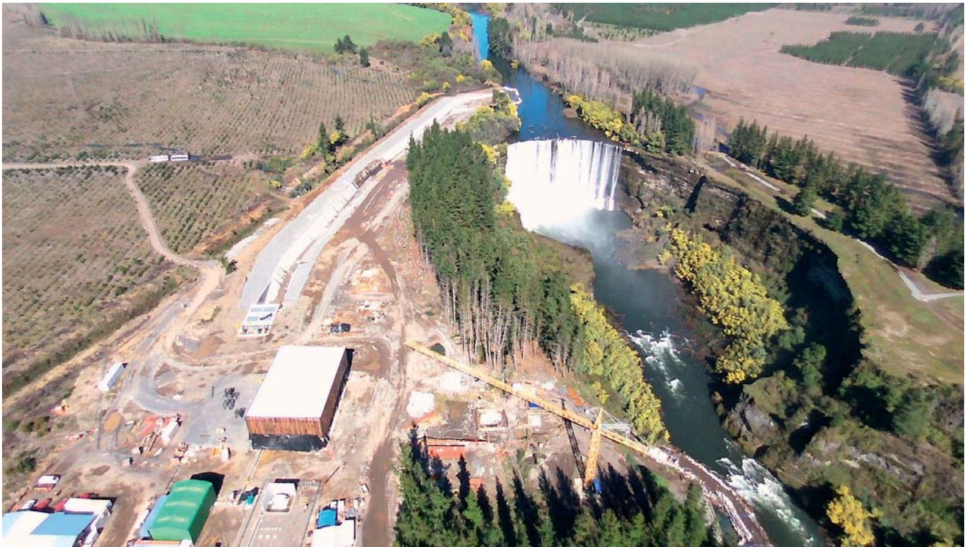
Instalaciones de la central en el Salto del Itata.
