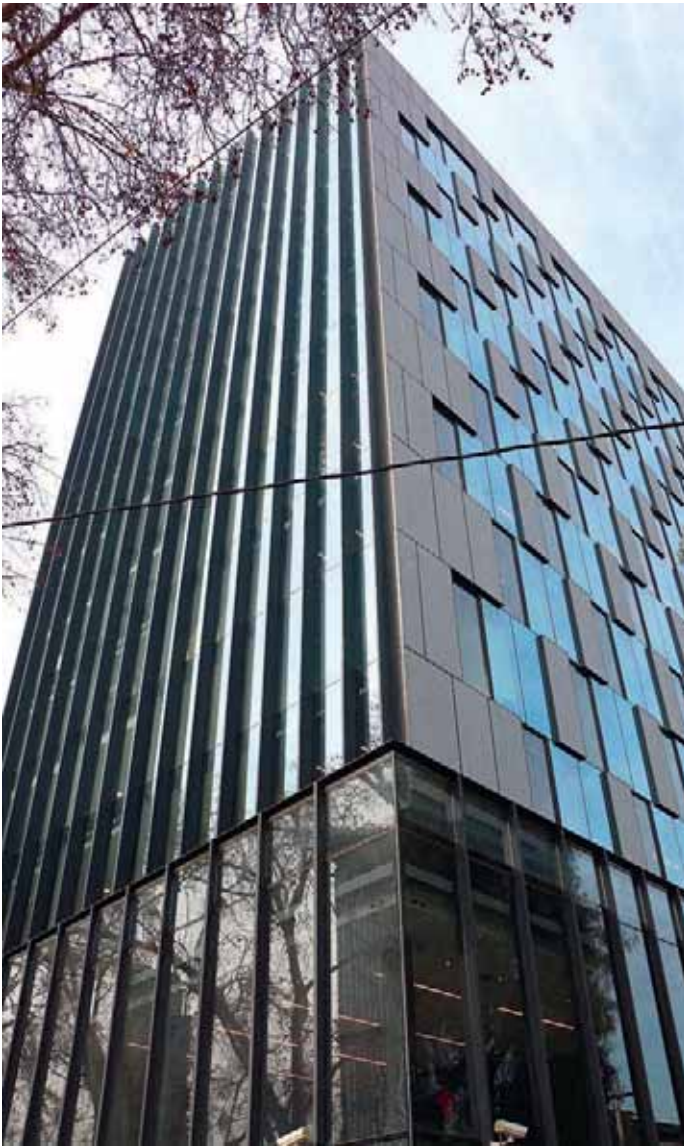
Edificio Corporativo Caja Los Andes, donde se hizo evaluación de control de clima, iluminación y cortinas motorizadas.
