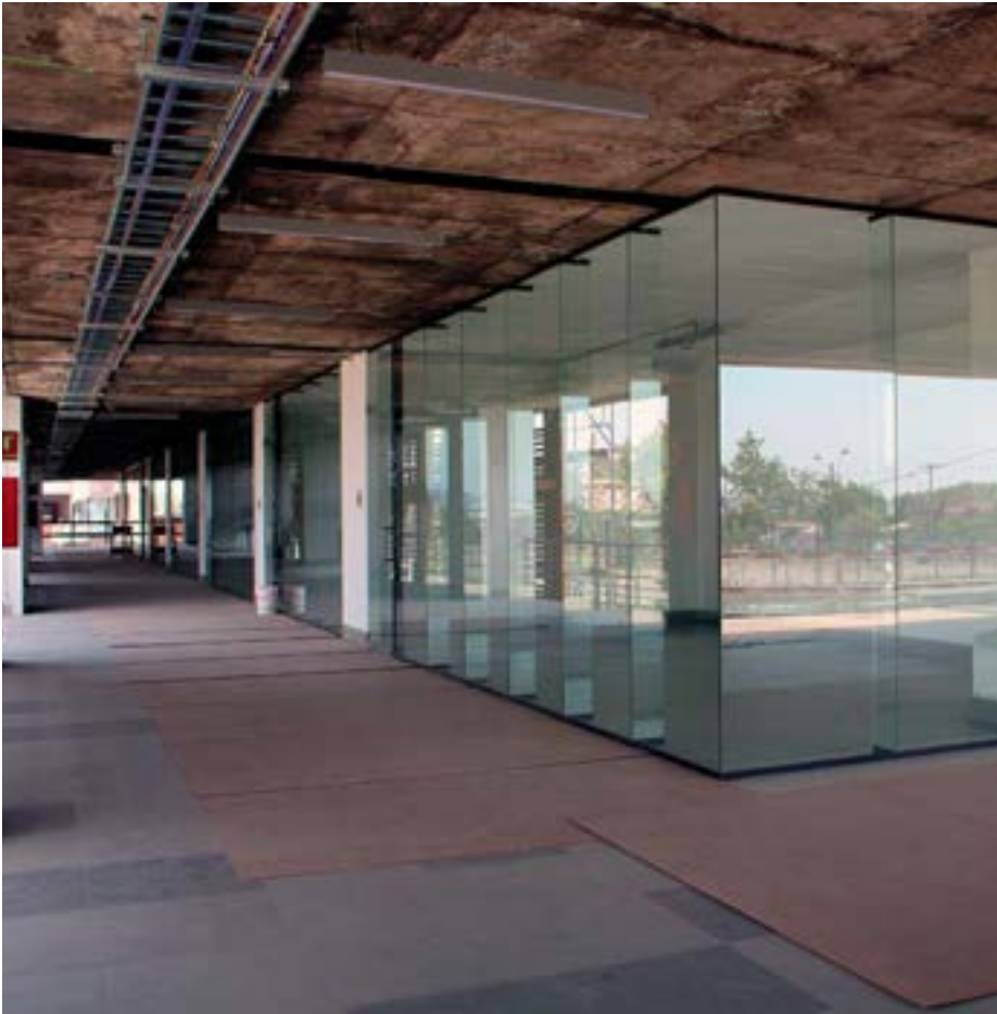
Para realizar el proyecto, no se tocó la estructura del edificio. No se demolieron lozas ni pilares.
