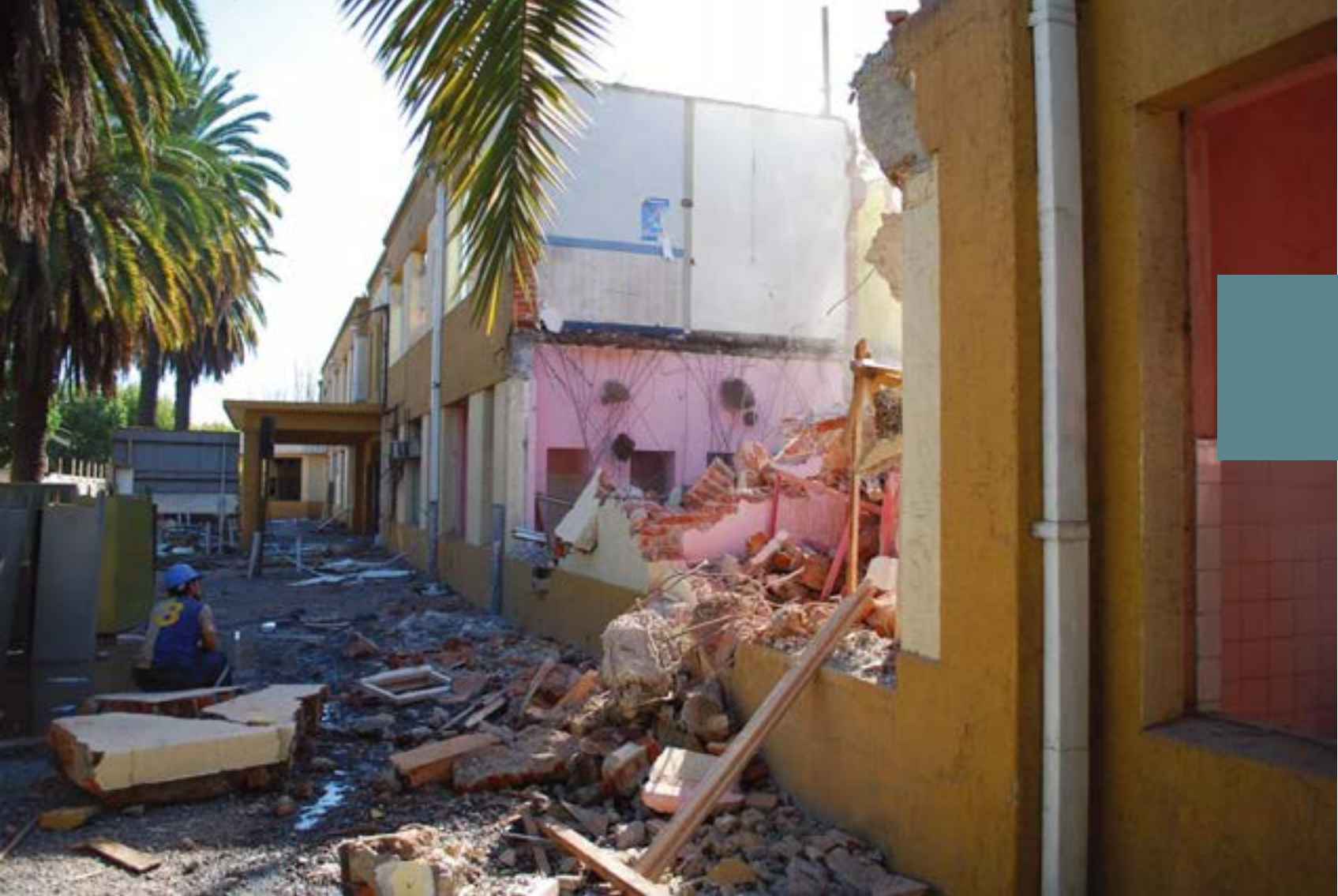
Hospital de Talca después del terremoto y posteriormente reconstruido.
