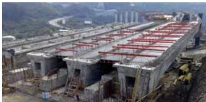
**LA ALTURA,** esbeltez y la misma geometría de las cepas requirió de un trabajo riguroso desde el punto de vista de la fabricación y de las dificultades físicas y de moldaje.
