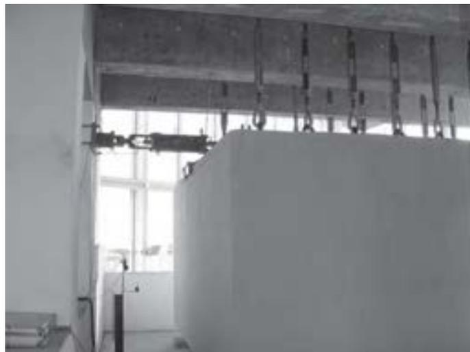
Amortiguador de masa sintonizada, edificio Parque Araucano.
