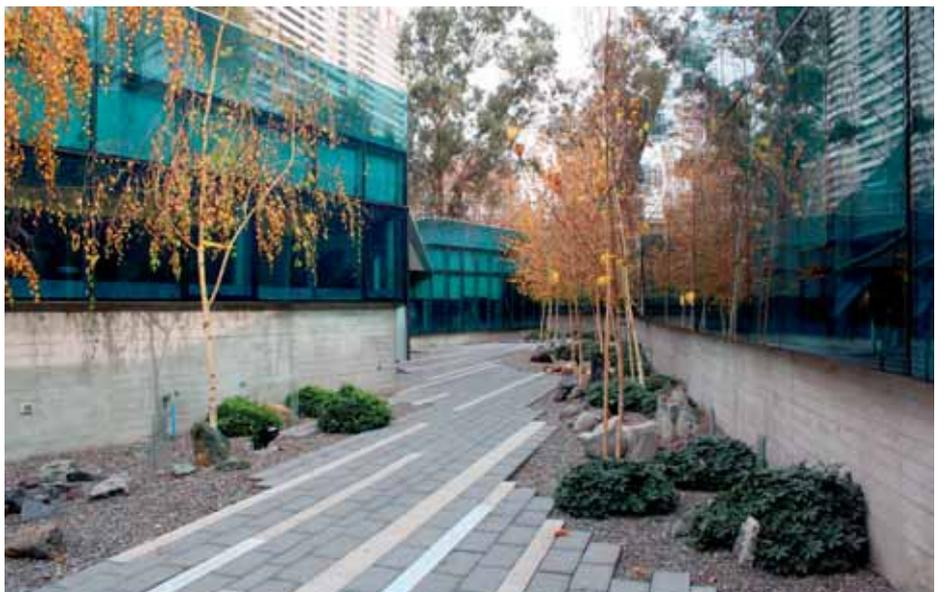
entonces, si arriba hay 27 ó 30°C, el hecho de que el edificio esté en sus costados y en el techo hundido, a 15 °C, hace que todo se enfríe. Por el contrario, si en invierno en el exterior hay menos de cero grado, la tierra sirve para elevar la temperatura. Entonces, el plus que hay que ponerle a la calefacción o al aire acondicionado es muy poco. Se estima el ahorro de energía en alrededor del 25%”, explica.
