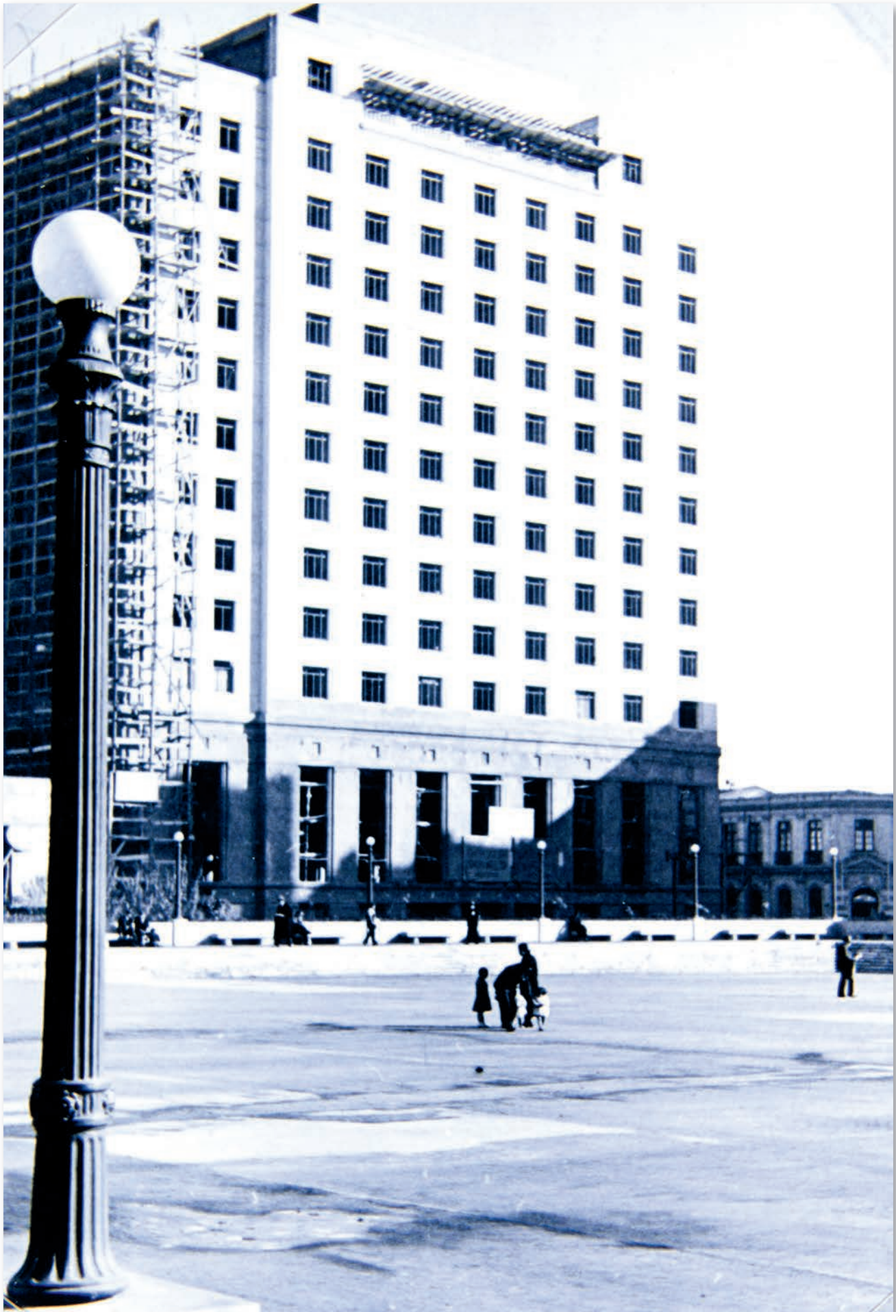
Construcción del Hotel Carrera, Santiago, Chile. 1940. Exterior del Hotel Carrera de Santiago en la fase final de su construcción.
