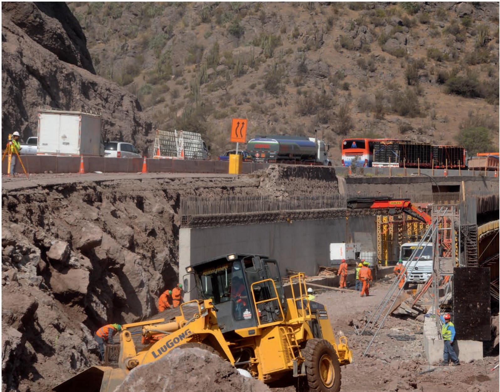
Las obras tuvieron como consecuencia los cortes de la Ruta 5 y las largas filas de automovilistas. Desde el 5 de diciembre, la situación se ha normalizado y el flujo es constante.
