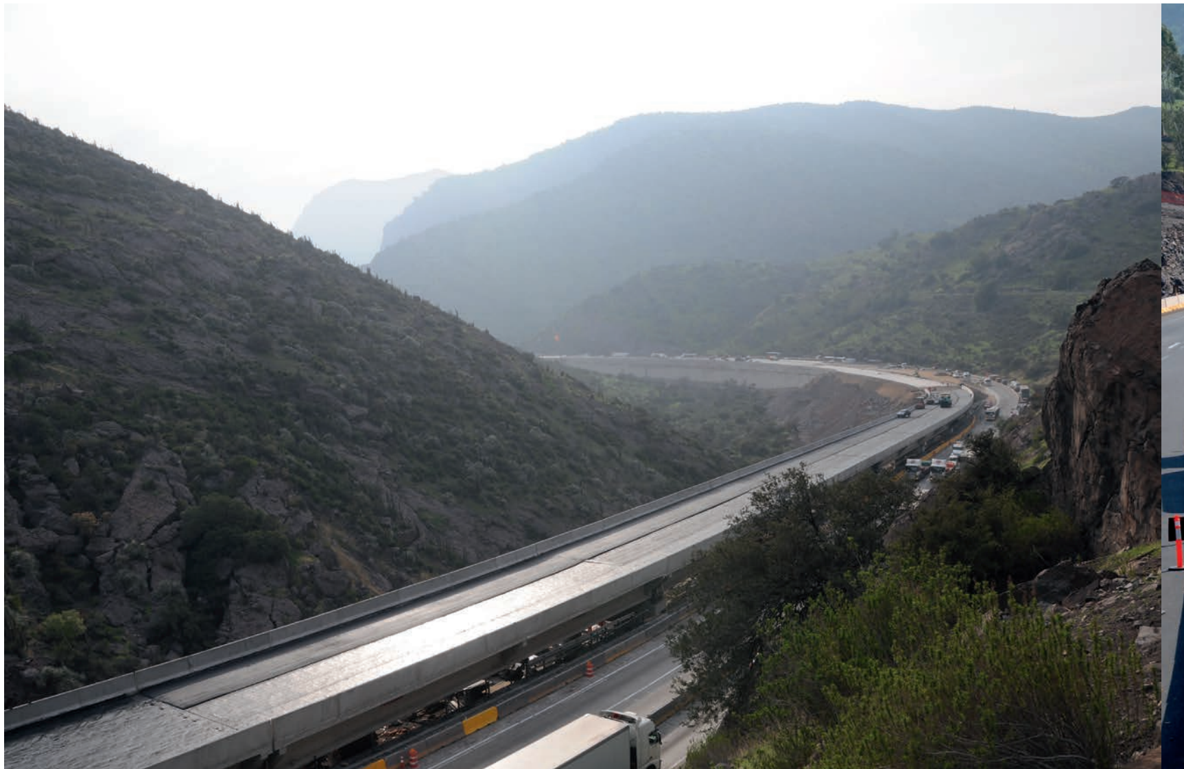
Se destaca la ejecución de un viaducto de casi 500 metros de longitud, instalado sobre una ladera de gran pendiente.
