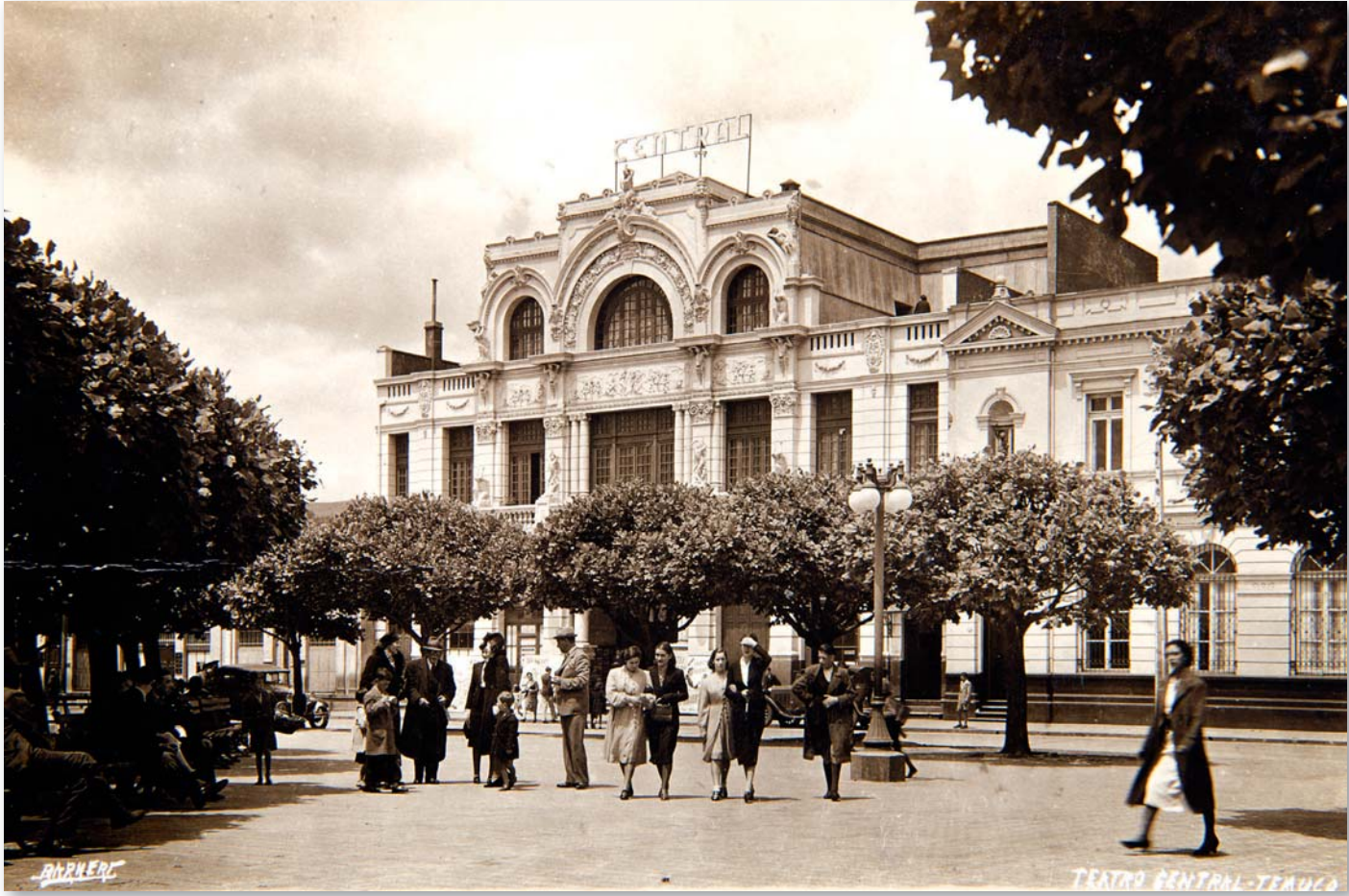
Teatro Central – Temuco, 1940. Imagen de la plaza Anibal Pinto de Temuco. Al fondo se aprecia el edificio del Teatro Central, en la calle Antonio Varas. Autor: Barnert. Alameda hacia el poniente, s.f. Perspectiva de la Alameda Bernardo O'Higgins hacia el poniente. En primer término se aprecia la esquina con calle Estado. Imagen de la primera mitad del siglo XX.
