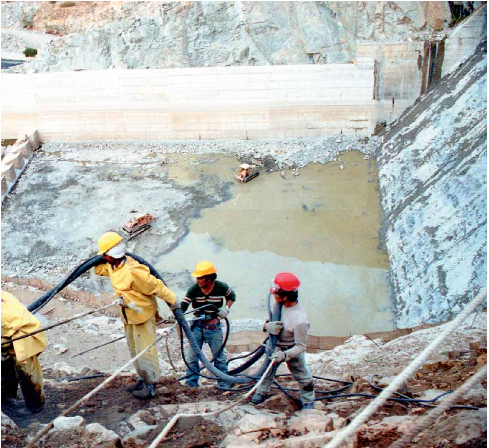
Arriba: Trabajos de encauzamiento del río Mapocho, 1888-9. Obreros trabajando en una zanja para encauzar el río Mapocho. Imagen de fines del siglo XIX. Abajo: Reparación del muro del embalse La Paloma, 1985. Un grupo de obreros aplican hormigón proyectado durante la reparación del muro del embalse La Paloma, región de Coquimbo. Obra realizada por la empresa Inela, Jack Ceitelis, fotógrafo.
