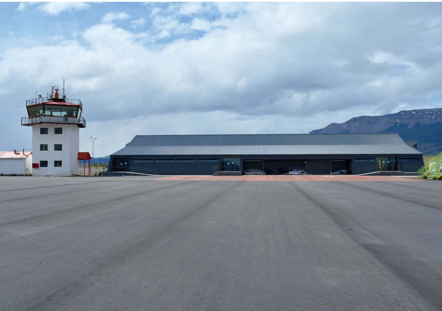
Vista del nuevo terminal aéreo hacia la pista de aterrizaje.
