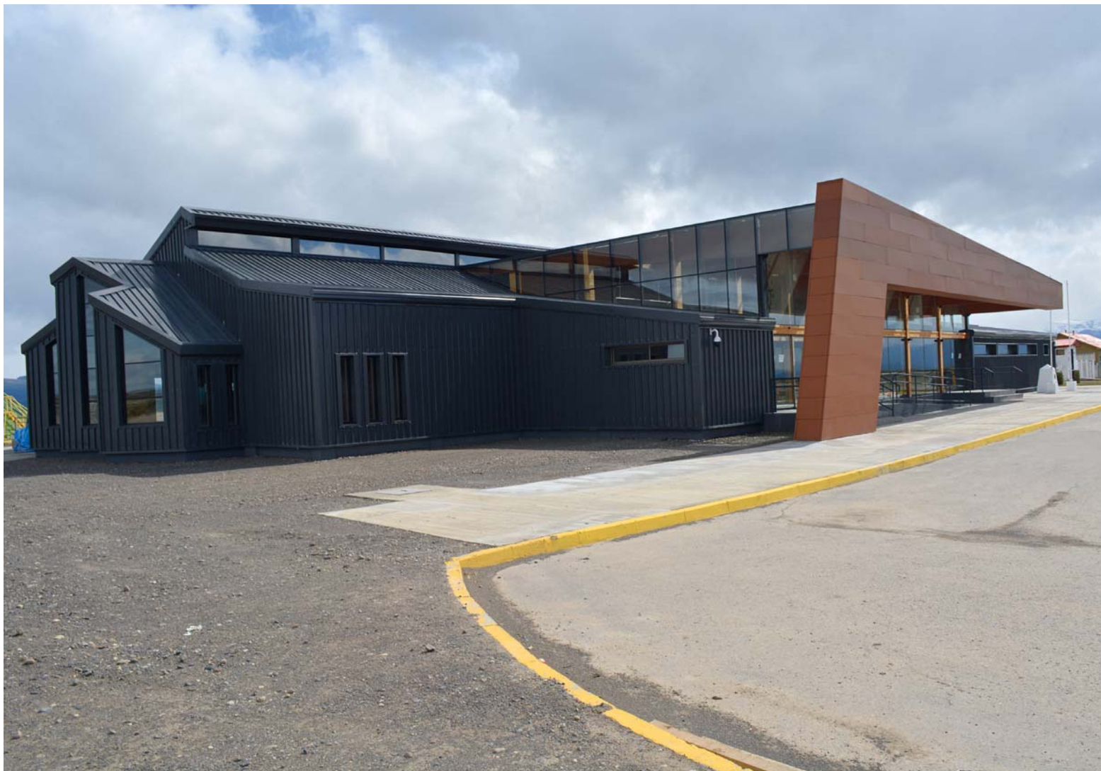
El terminal aéreo pasó de tener 500 a 1.200 metros cuadrados.
