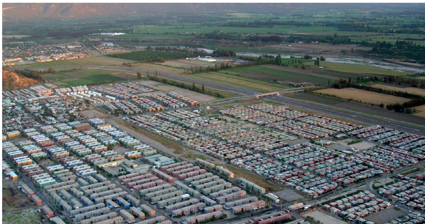
Bajos de Mena.
