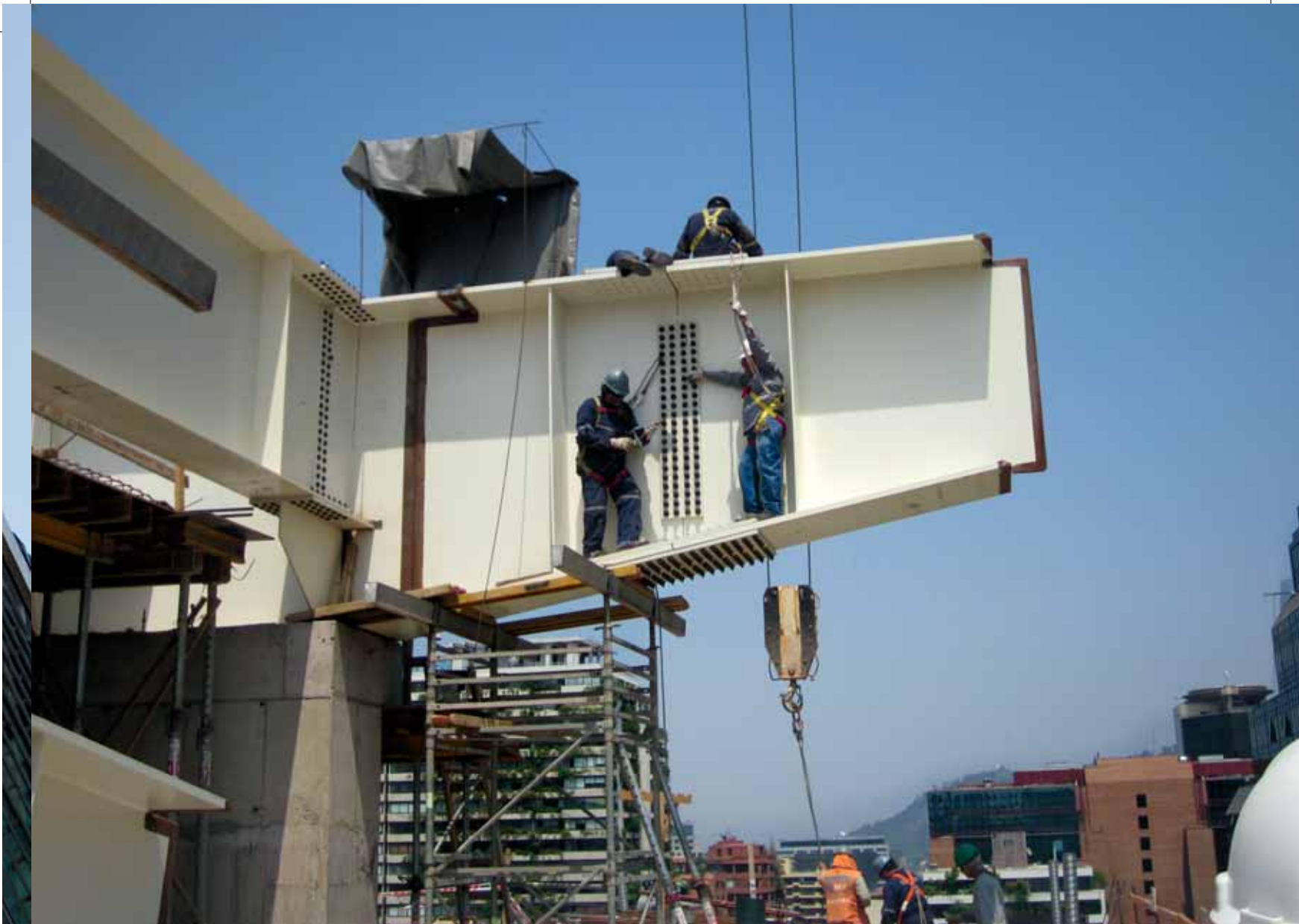
Vista del montaje de vigas maestras, nivel cubierta. Foto: VMB Ingeniería Estructural.
