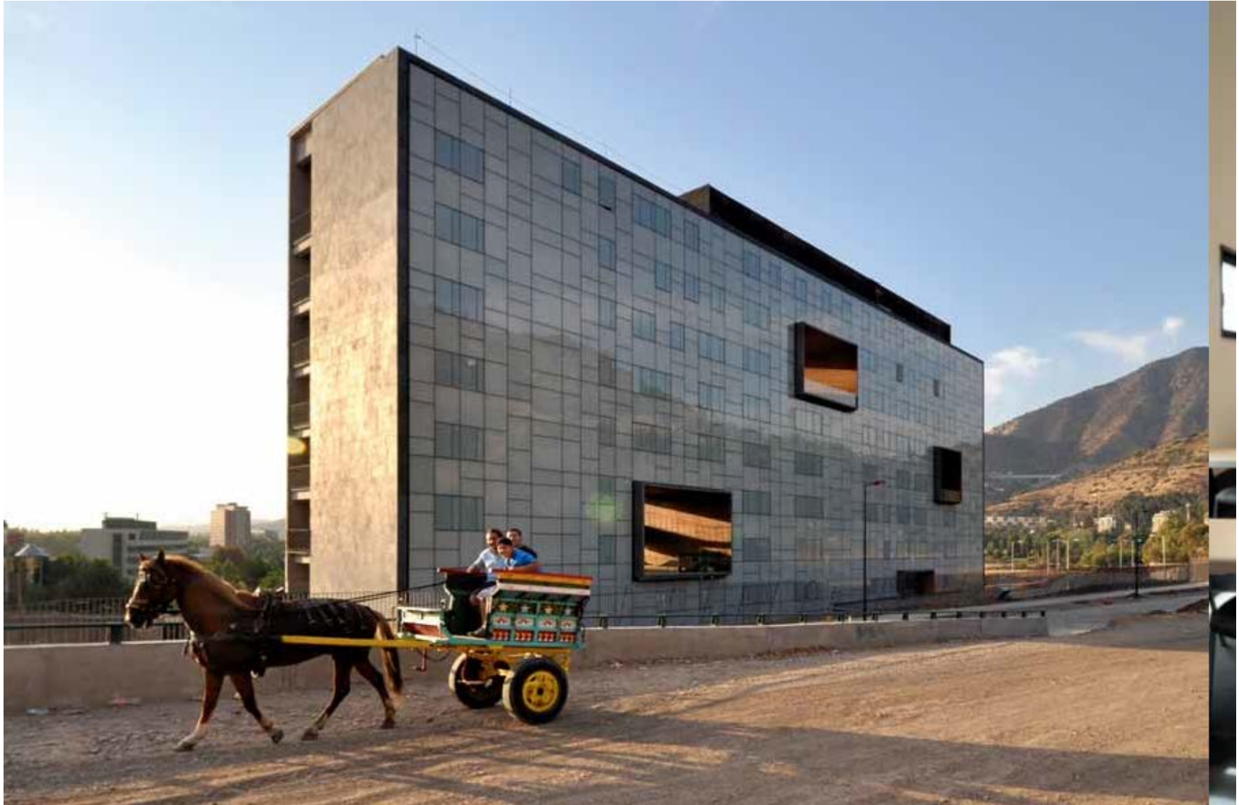
Vista posterior del edificio "barra".
