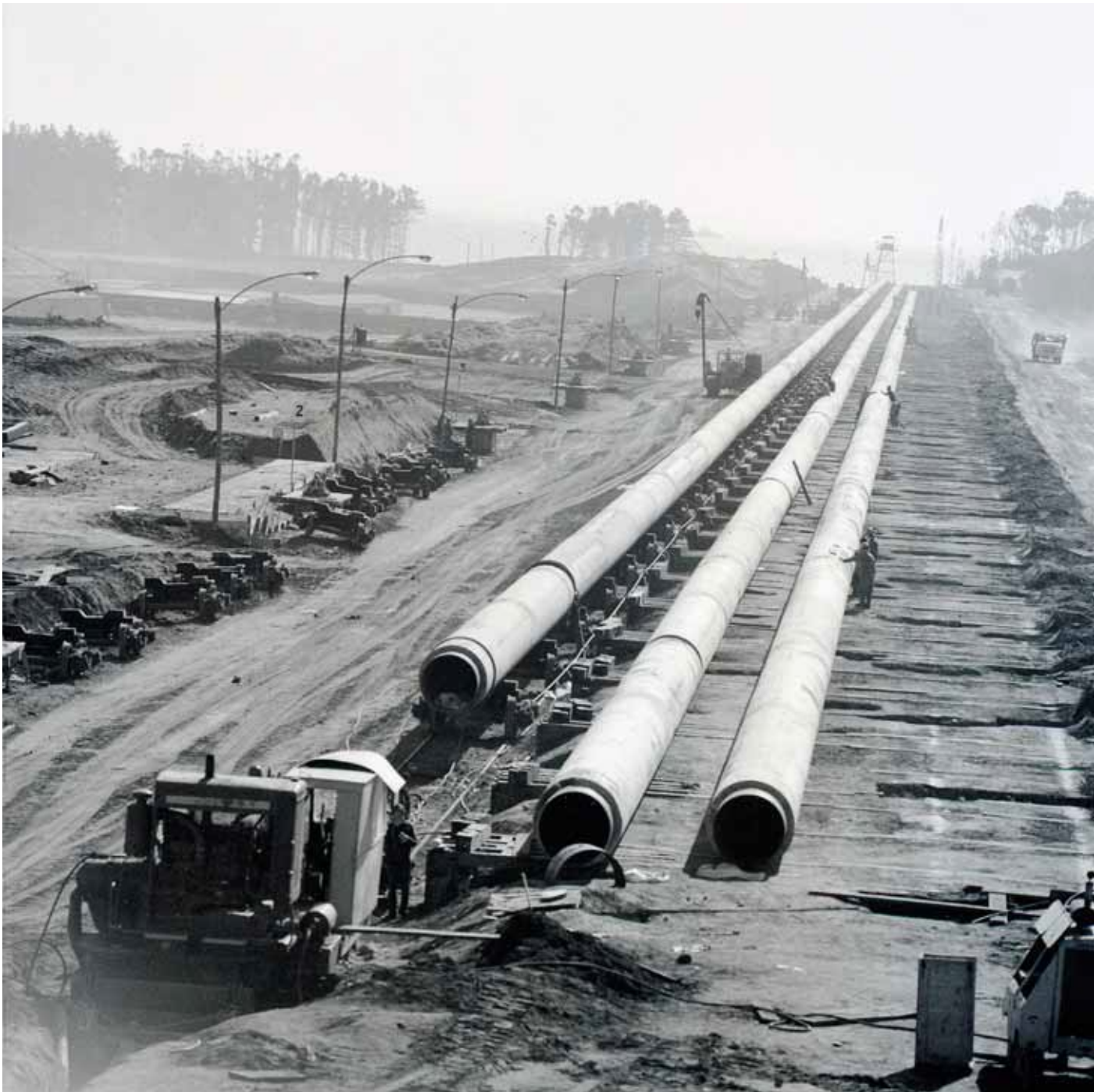
----- Instalación de tuberías subterráneas en el puerto de Quintero, 1971. (Jack Ceitelis, fotógrafo).
