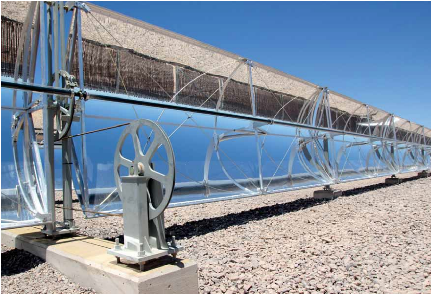
El ahorro de más de la mitad del combustible fósil utilizado cada año en Minera El Tesoro, será posible gracias a la tecnología cilindro parabólica implementada en la planta.
