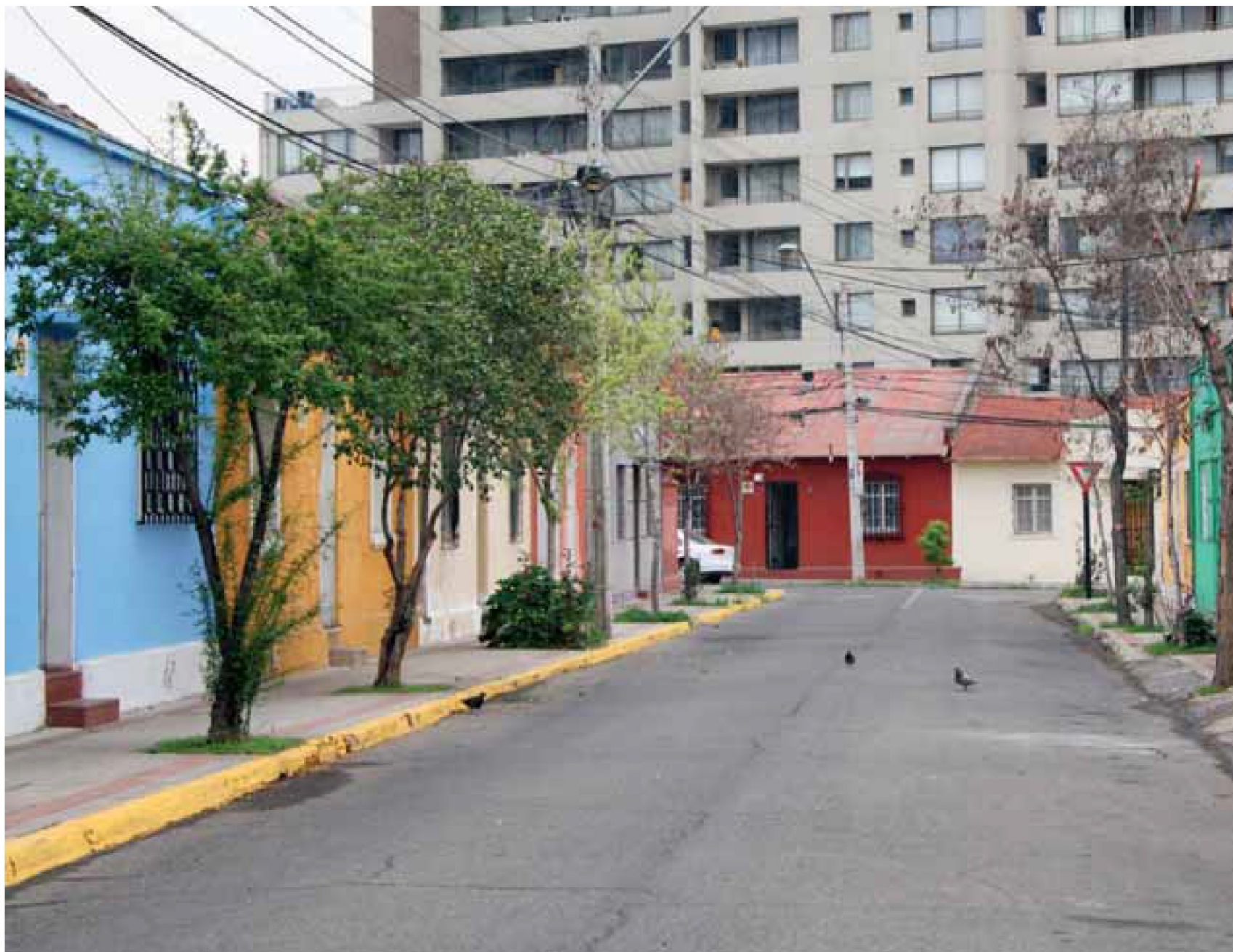
Basadas en el diseño del arquitecto Luciano Kulczewski, las casas del sector son de una sola planta y se revisten de diversos colores.
