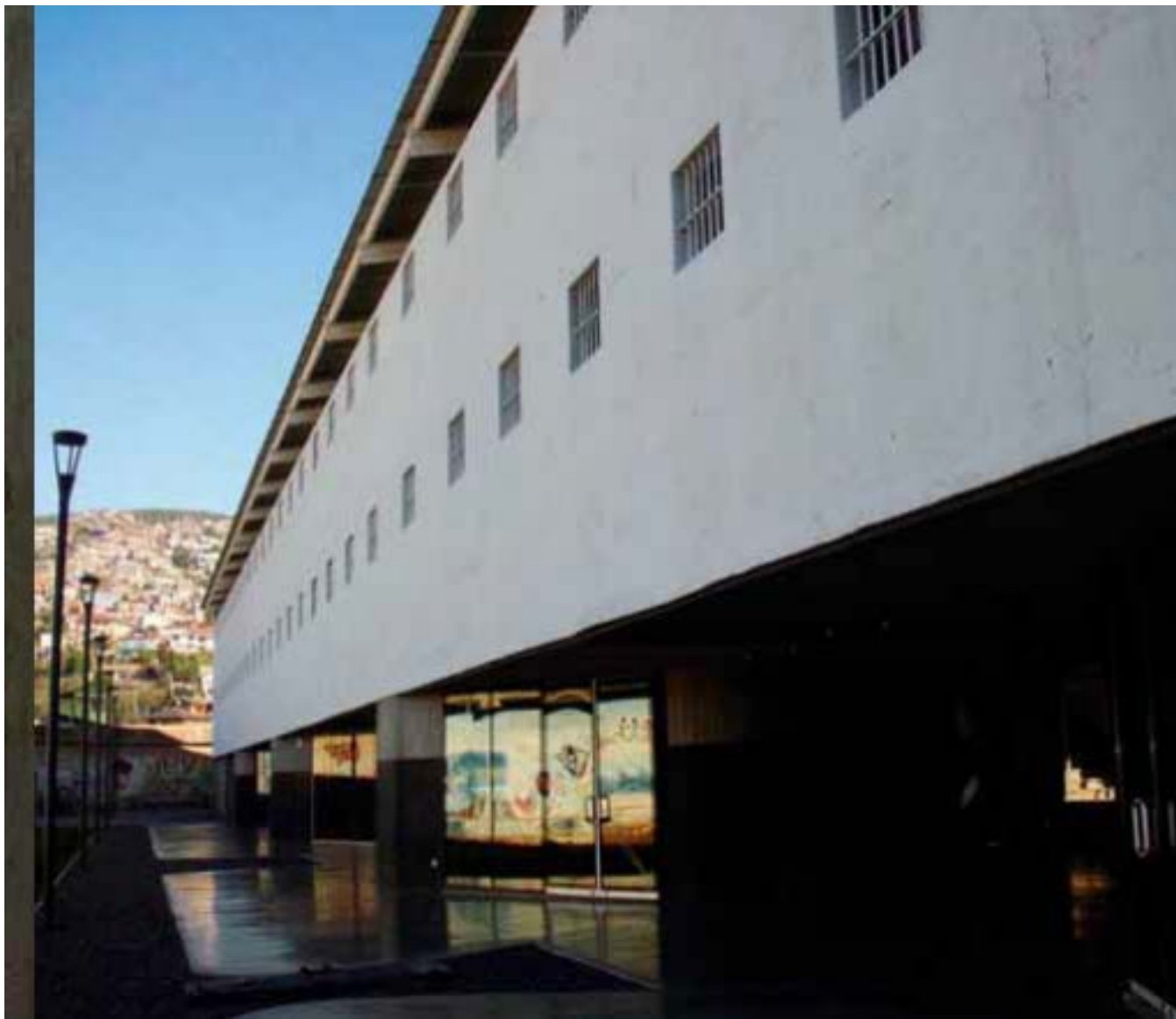
El desafío de la obra era convertir un espacio cerrado, en uno abierto tanto al público como a quienes quisieran hacer uso de las instalaciones.
