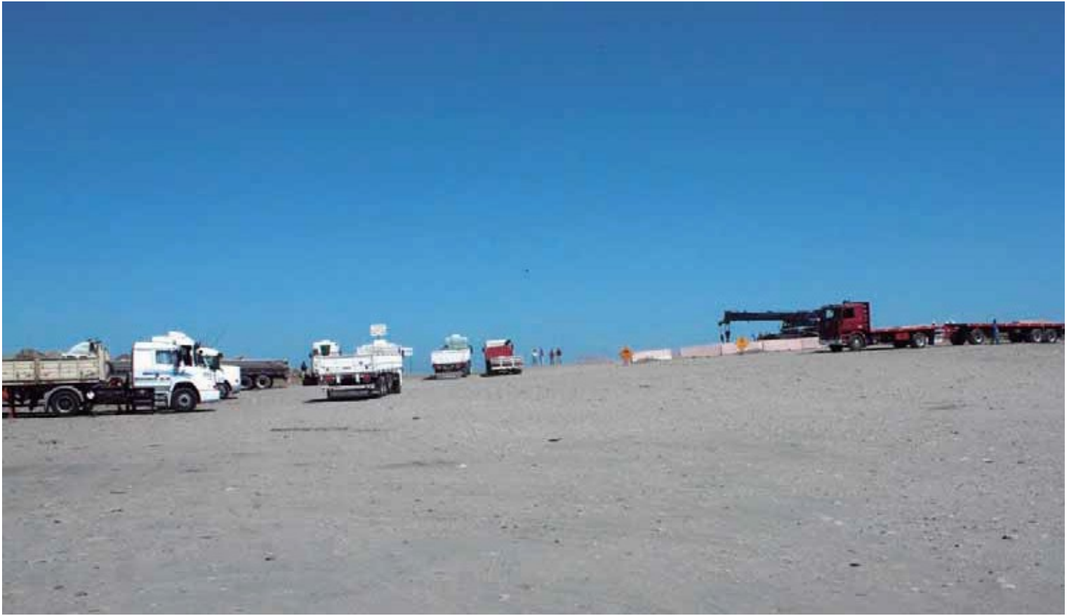
Para solucionar los efectos negativos que tiene el puerto en la ciudad, por el gran número de camiones que transita diariamente, EPSA ya está trabajando en la construcción de un truck center.
