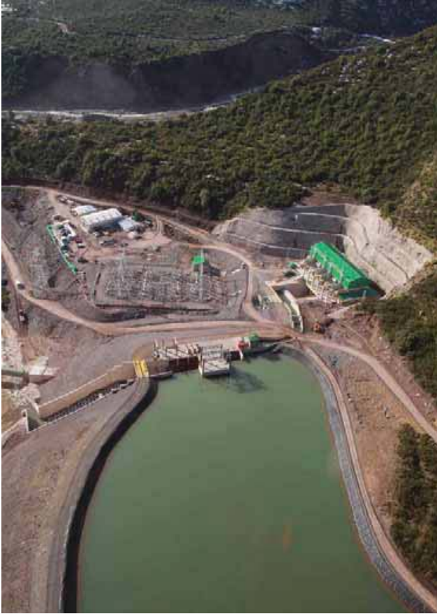
Vista de hidroeléctricas La Higuera y La Confluencia.
