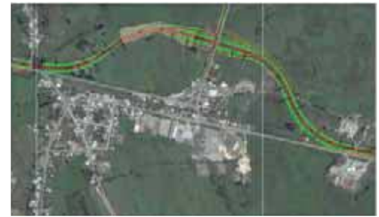
By pass Carampangue y nuevo acceso a Arauco
