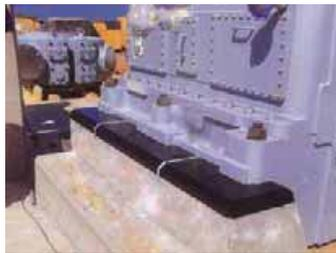
BASE GENERADOR, GROUTEADO CON PRODUCTO F.S.DP EPOXY GROUT.
