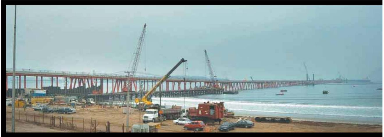
da por un muelle de 1.850 metros, sostenido por quinientos pilotes. Tiene instalados cinco brazos de descarga de GNL y una sala de control. La segunda está formada por el área de procesos, donde se encuentran los tres vaporizadores, los compresores, el recon- densador y otros equipos necesarios para la operación. La tercera fracción está com- puesta por los tres estanques de GNL –dos de los cuales están en construcción- por un total de 334.000 m<sup>3</sup> de almacenamiento. El
