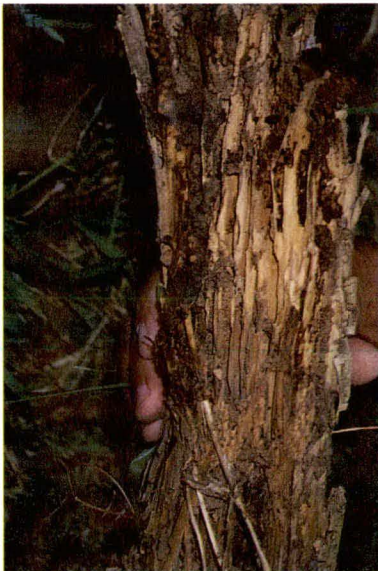
Daño generalizado en rollizo sin impregnar.
