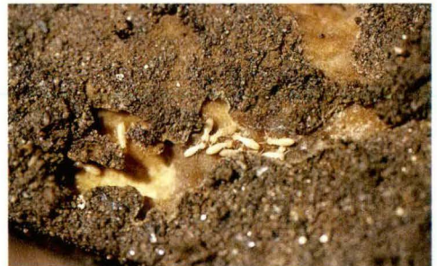
Vista general, termitas subterráneas en galerías en madera que estaba enterrada.
