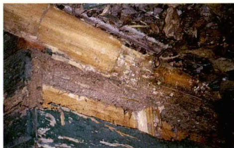
Paño en estructura en exterior.
