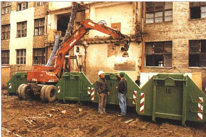
Cancha de transferencia descentralizada.
