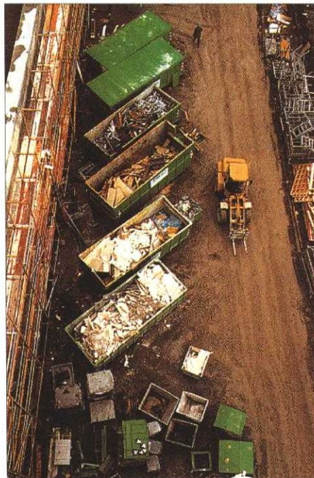
Cancha terminal de despacho.
