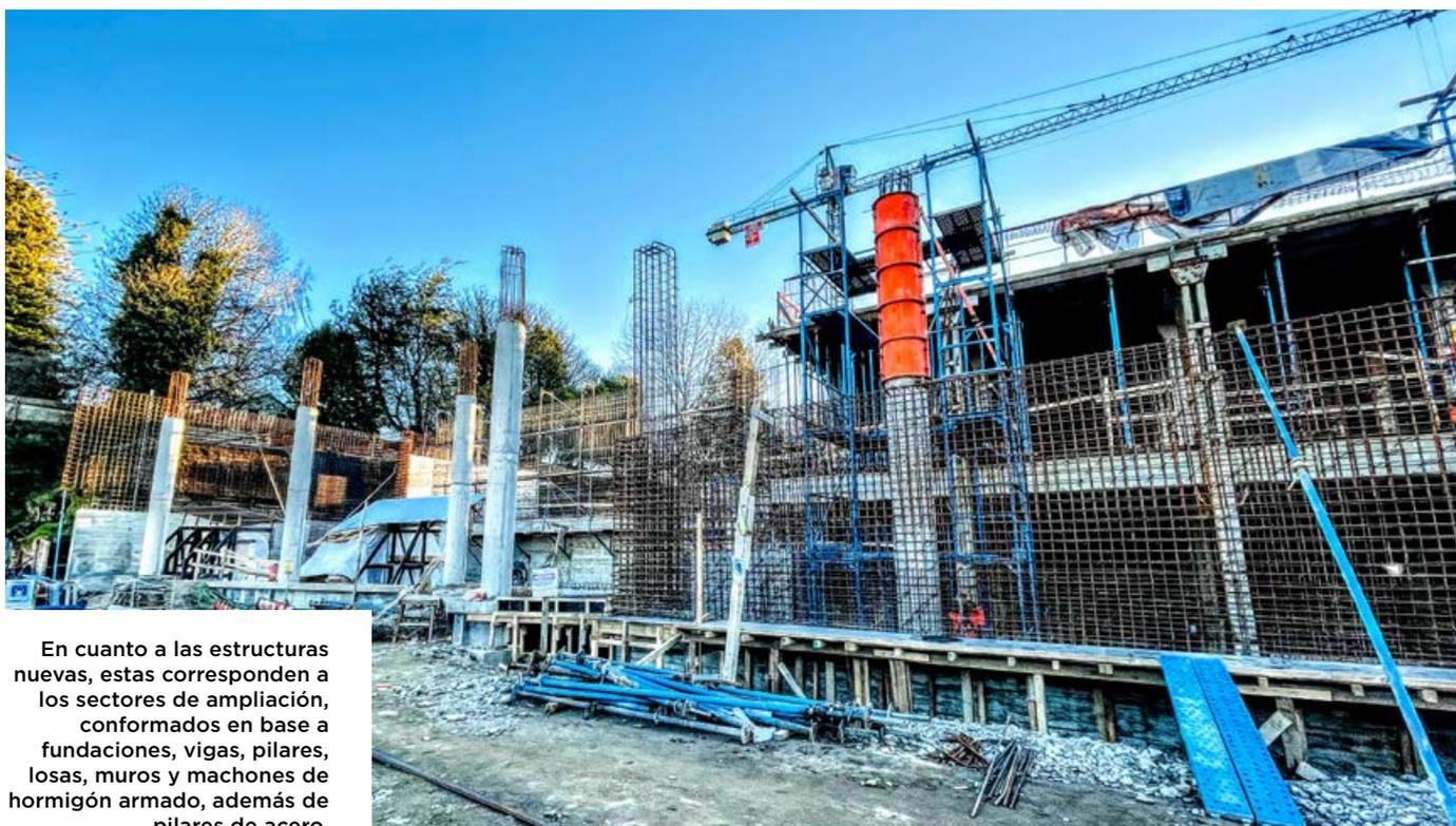
En cuanto a las estructuras nuevas, estas corresponden a los sectores de ampliación, conformados en base a fundaciones, vigas, pilares, losas, muros y machones de hormigón armado, además de pilares de acero.
