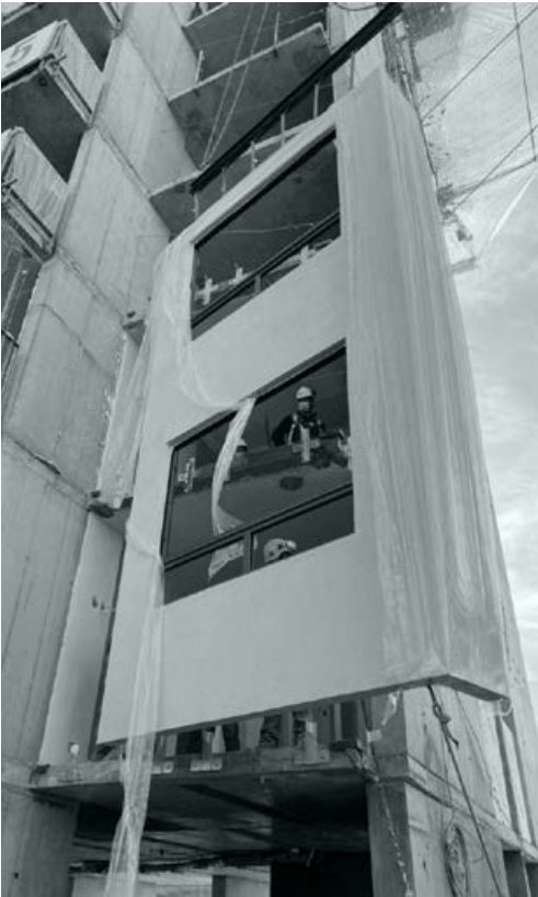
La parte final consistió en terminar el panel por la cara interior, conformando el tabique.
