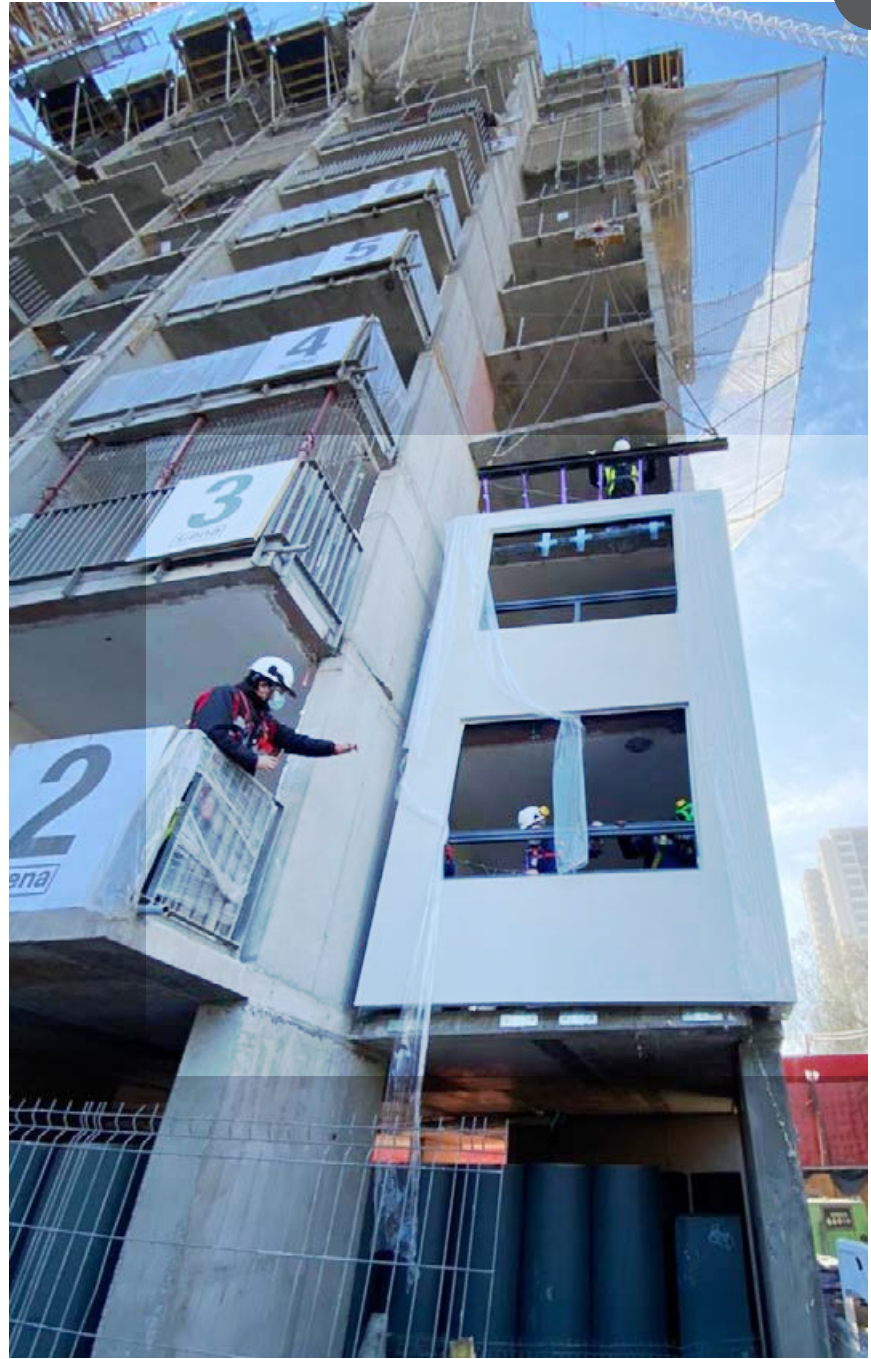
La parte final consistió en terminar el panel por la cara interior, conformando el tabique.
