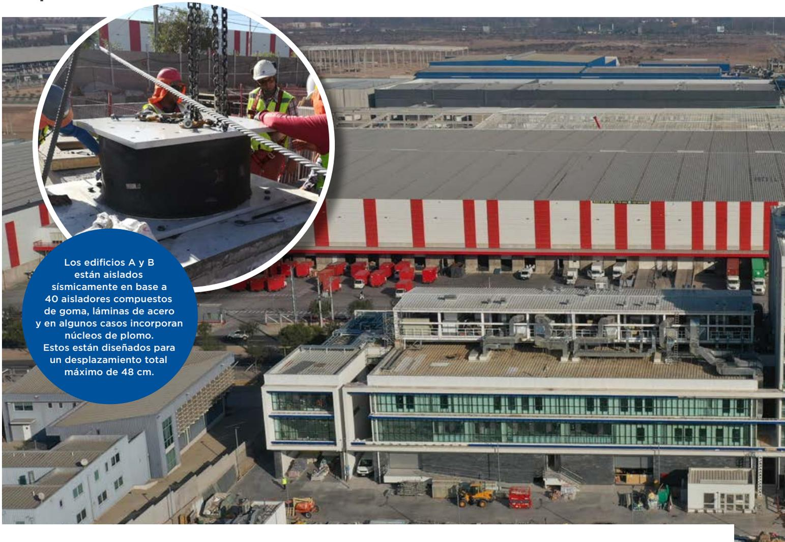
Los edificios A y B están aislados sísmicamente en base a 40 aisladores compuestos de goma, láminas de acero y en algunos casos incorporan núcleos de plomo. Estos están diseñados para un desplazamiento total máximo de 48 cm.
