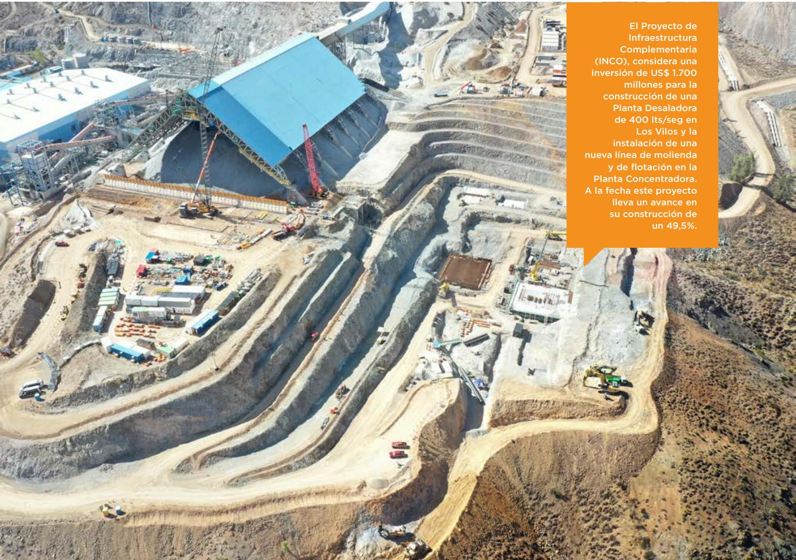
El Proyecto de Infraestructura Complementaria (INCO), considera una inversión de US\$ 1.700 millones para la construcción de una Planta Desaladora de 400 lts/seg en Los Vilos y la instalación de una nueva línea de molienda y de flotación en la Planta Concentradora. A la fecha este proyecto lleva un avance en su construcción de un 49,5%.
