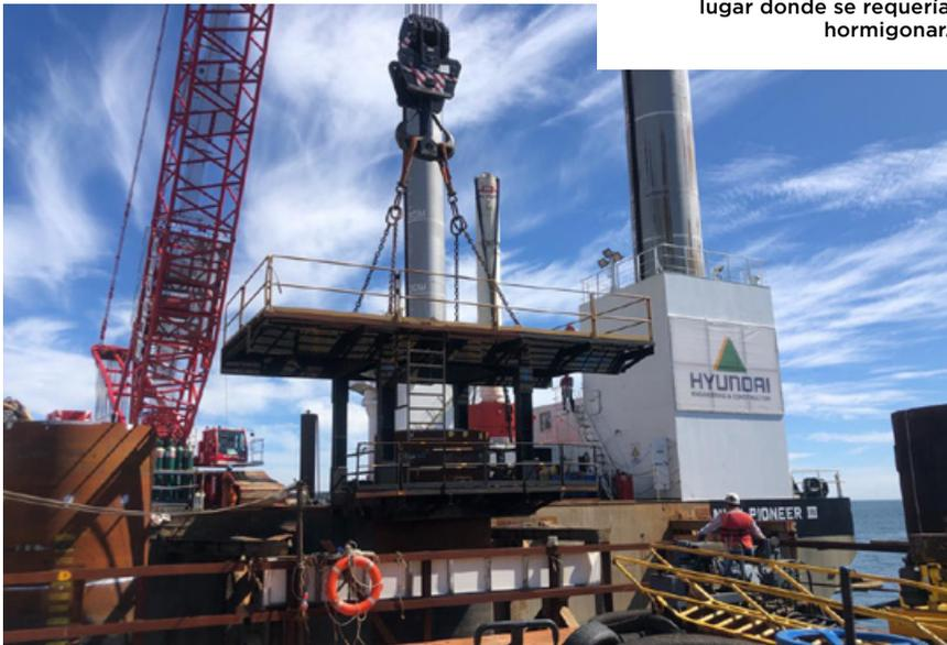
La obra se inició con la construcción de 36 pilotes para soportar la pila central del puente. Cada pilote tiene aproximadamente 55 metros de longitud, un diámetro nominal de 2,65 metros y se sumergen a 40 metros bajo el lecho marino.
