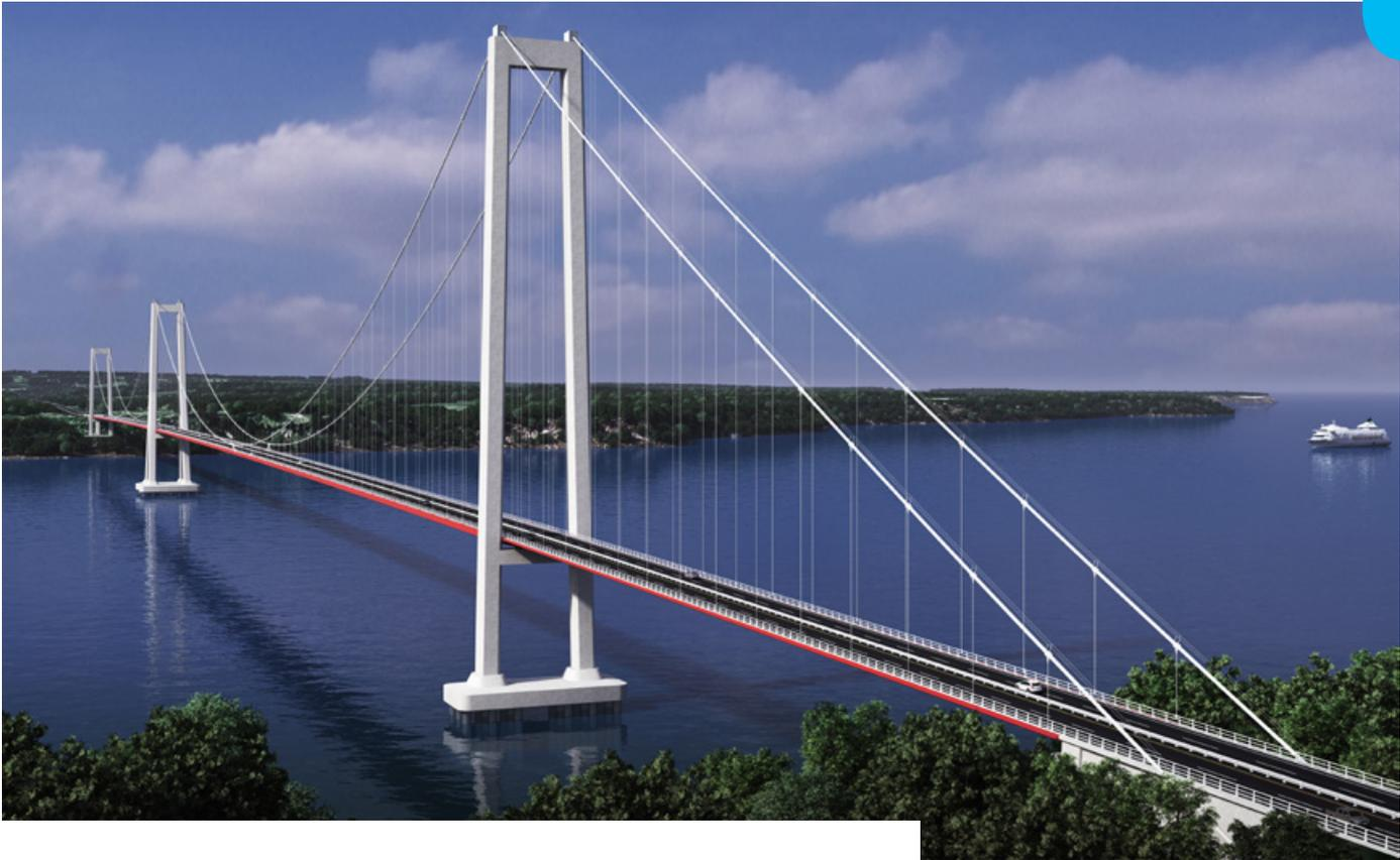
Con una longitud total de 2.750 m, el puente Chacao unirá los sectores de Punta Coronel en el Continente y Punta San Gallan en la Isla de Chiloé. Será del tipo colgante continuo en dos tramos de 1.155 y 1.055 m en los lados norte y sur, respectivamente, con cuatro pistas de circulación de 3,5 m cada una con berma exterior de 1,5 m, para una velocidad de circulación de 80 km/h.
