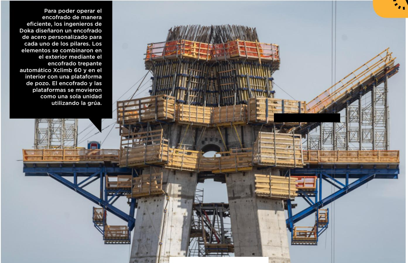
se disiparon de manera segura en la sección de hormigón debajo sobre una plataforma de trabajo de vigas de acero sólido a través de soportes. El diseño incluía una función para bajar la plataforma para que posteriormente se pudiera retirar el encofrado del hormigón.
