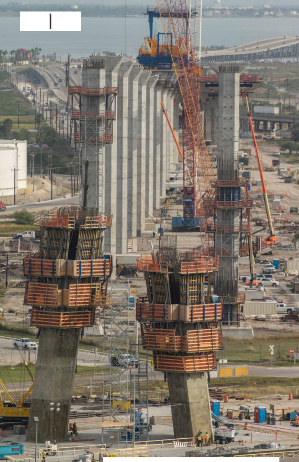
El nuevo Puente del Puerto US 181, que tendrá una capacidad considerablemente mayor que la estructura que está reemplazando. Se recurrió al uso de encofrados para ayudar a construir los pilones de 164 metros de altura y más de 100 pilares.
