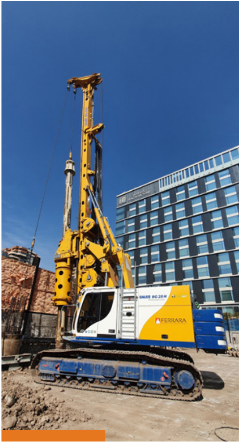
Edificio Nueva Las Condes 3.0 / Cliente: Constructora Ignacio Hurtado / Tecnología: Pilotes Anclados
