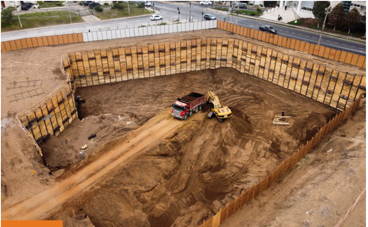
Edificio Roquetas - Viña del Mar / Cliente: Inmobiliaria Cerro Alegre / Tecnología: Muro Berlinés
