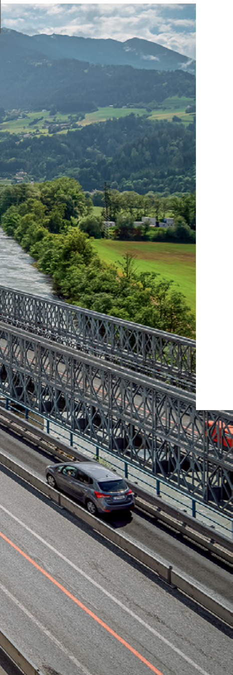
El Terfener Innbrücke, que mide aproximadamente 235 m de longitud, está situado en la autopista A12, en el valle de Inntal, en el Tirol.
