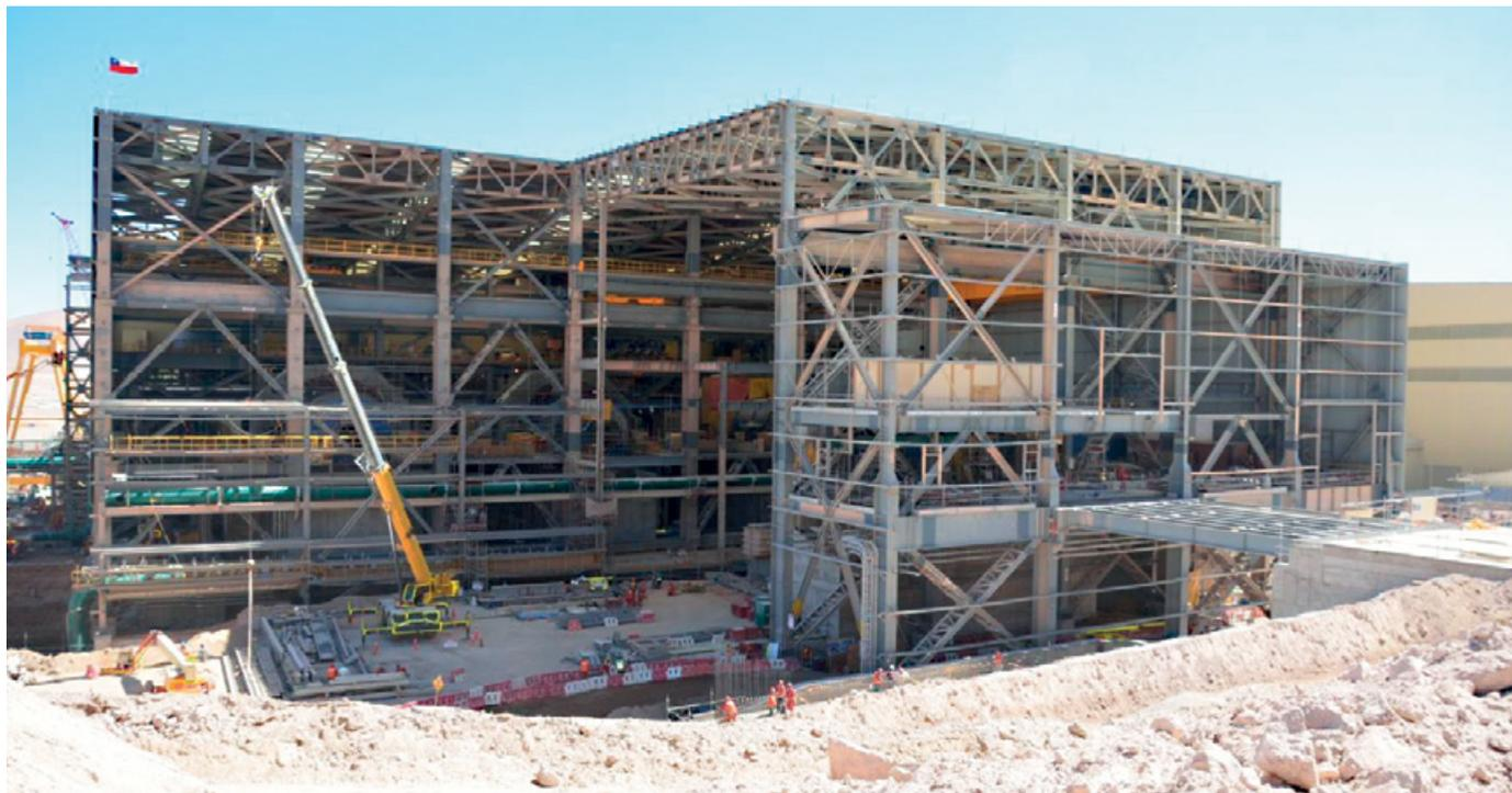
EDIFICIO DE MOLIENDA DEL PROYECTO OGP1. JUNTO CON EL VOLUMEN DE ESTRUCTURA UTILIZADA, OTRO DESAFÍO IMPORTANTE FUE EL DETALLAMIENTO Y FABRICACIÓN DE PERFILES DE GRAN TAMAÑO Y CON PLANCHAS DE 63,75 E INCLUSO 100 MM DE ESPESOR.
