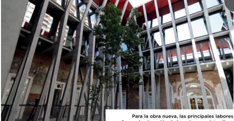
fueron la ejecución de hormigones vistos lisos arquitectónicos de muros, losas, vigas y cielo, junto con la ejecución de los pilares de Hormigón Armado (H.A.) de la fachada del patio interior (en las fotos).
