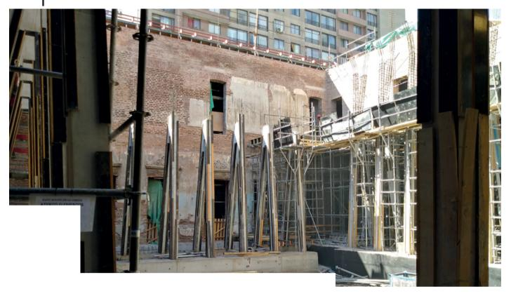
Antes de realizar cualquier intervención, se ejecutó un levantamiento al detalle de los daños, tales como fisuras, grietas y desaplomes. El principal desafío en términos estructurales fue devolver la resistencia a la estructura de albañilería original, mediante diferentes operaciones que consideraban técnicas tradicionales y contemporáneas.
