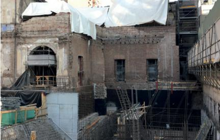
Las principales acciones estructurales ejecutadas fueron: la construcción de un diafragma rígido en concreto (una losa sobre el envigado original de 7 cm, que podría mantener todas las fachadas juntas. Junto a ello, refuerzos en cada vano existente con un marco embebido de 10 mm de espesor, los que resolvieron los problemas de estabilidad que tenía la estructura.
