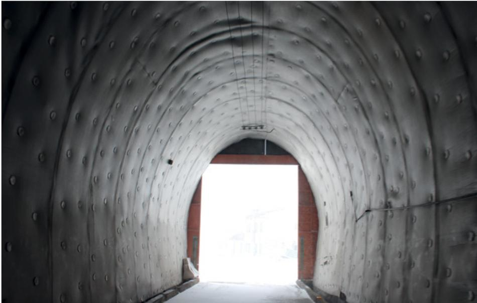
Tanto en las galerías, como en la ampliación de los túneles, el soporte será en general mediante pernos pasivos y shotcrete con o sin fibra (metálica). Ocasionalmente está previsto el uso de marcos reticulados, malla electrosoldada y hormigón. Eventualmente se considerarán tratamientos de impermeabilización con inyecciones cementicias y/o químicas.
