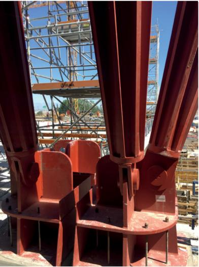
El Terminal T2M del Aeropuerto AMB está estructurado en base a marcos rígidos de estructura de acero, rotulados en la base. "Una de las particularidades que tienen las columnas principales es que se trata de cuadrípodos (en las zonas interiores del edificio), y de trípodos y bípodos (en el caso de las columnas perimetrales).
