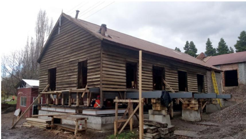
En la estructura de madera de los muros, “se repararon todos los elementos en mal estado (soleras inferiores, pies derechos, etc.), replanteando las alturas de los muros desde la solera superior hacia abajo. Una vez terminada las reparaciones, se procedió a bajar la casa para trabajar en las instalaciones, aislación y revestimiento; utilizando para ello, elementos existentes y otros nuevos de acuerdo a proyecto”, anota el inspector fiscal Rodrigo Tapia.
