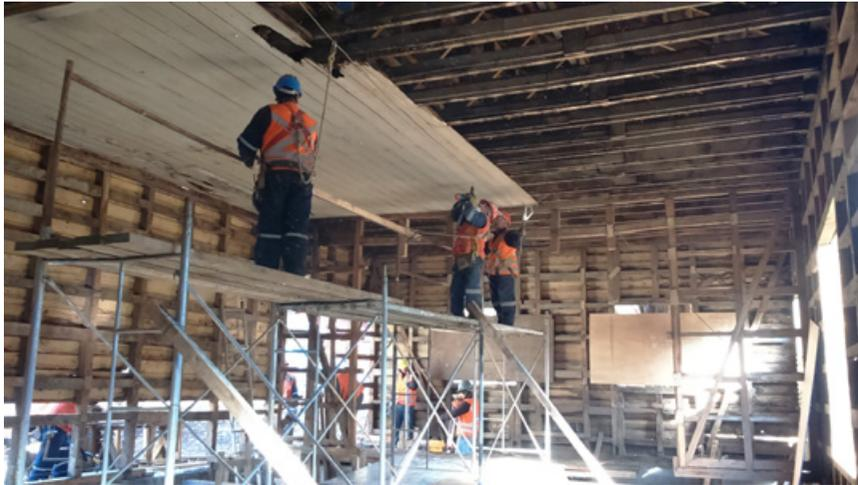
En la estructura de techo, se reemplazaron las piezas en mal estado, se niveló la parte baja para mantener un cielo horizontal, se instalaron placas de OSB y membrana contra la humedad para luego reinstalar las tejas de madera de alerce existentes junto con tejas nuevas para suplir las que no pudieron ser reutilizadas.
