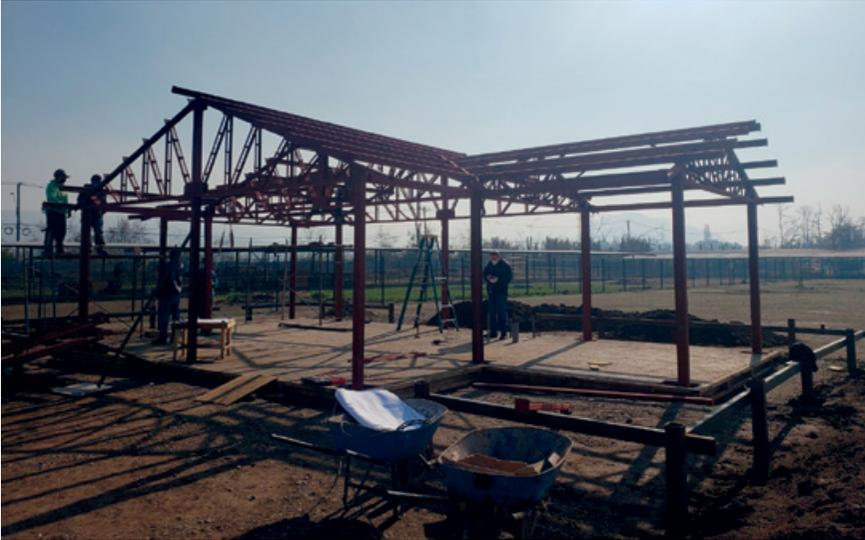
En cuanto al montaje de la obra, desde TWH indican que tomó un periodo de tres días y medio aproximadamente en terminar la obra gruesa: un día y medio en montaje de estructura y dos días en montajes de los paneles. El proceso contempla una cuadrilla de cuatro personas para las instalaciones. La estructura metálica puede ser cargada, sin necesidad de maquinaria pesada.
