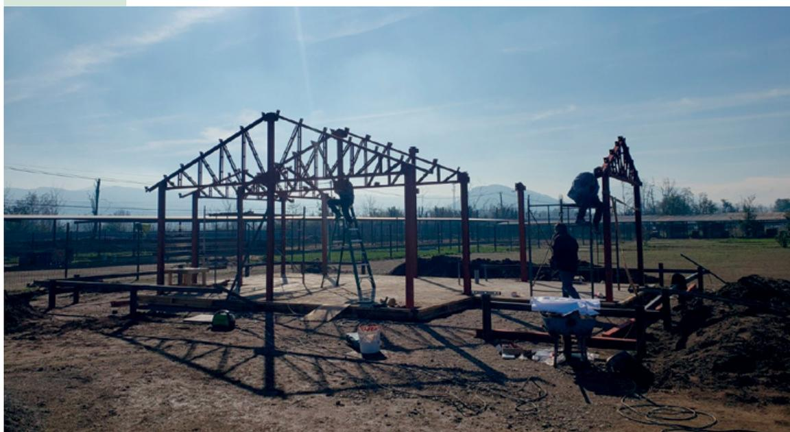
TWH es un brazo de la empresa IMEL, especialista en acero. Por tal motivo, la estructura tipo mecano del piloto es metálica y autosoportante, la cual se arma con la ayuda de pernos. De acuerdo a sus desarrolladores, este tipo de estructura junto a los paneles, aportan a la rebaja en tiempos de construcción, disminuyen los escombros producidos en obra y resultarían en menores costos, entre otros beneficios.
