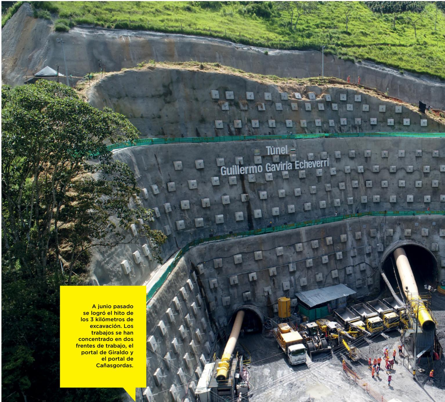
A junio pasado se logró el hito de los 3 kilómetros de excavación. Los trabajos se han concentrado en dos frentes de trabajo, el portal de Giraldo y el portal de Cañasgordas.
