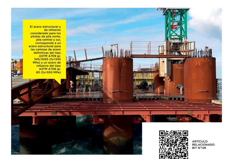
diseño definitivo. En cuanto a los pilotes, éstos se clasifican en dos tipos. El tipo 1, que tiene una longitud de camisa de L=55,00 m (cota -47 NMM), y una longitud total de L=85,95 m (cota -78 NMM) y el tipo 2, que tiene una longitud de camisa de L=59,00 m (cota - 50,5 NMM), y una longitud total de L=89,45 m (cota - 81,5 NMM). Por su parte, el lecho marino está a una profundidad entre los -21,5 NMM a -27,5 NMM.
