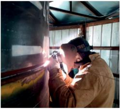
y tintas penetrantes) y verificado la calidad de soldadura, se procedió a ejecutar el hincado del tramo final o total de la camisa considerando la longitud del tramo superior e inferior en cuestión, hasta la cota de proyecto especificada. El tramo inferior comenzó en el hincado con un vibromartillo de 40 toneladas para luego pasar a un martillo hidráulico o martinete de 3 m de diámetro y 120 toneladas, que se utilizó también para el hincado del tramo superior.
