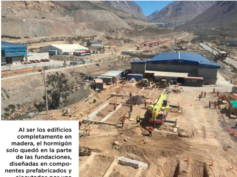
Al ser los edificios completamente en madera, el hormigón solo quedó en la parte de las fundaciones, diseñadas en componentes prefabricados y ejecutadas por una empresa colaboradora en la planta de San Bernardo de Tecno Fast.
