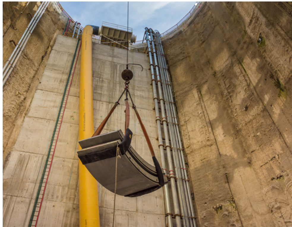
TÚNEL EJECUTADO POR LA TUNELERA BEATRIZ. Abajo: dovelas bajando por uno de los piques de gran diámetro construidos para bajar las TBMs, entre otros equipos.
